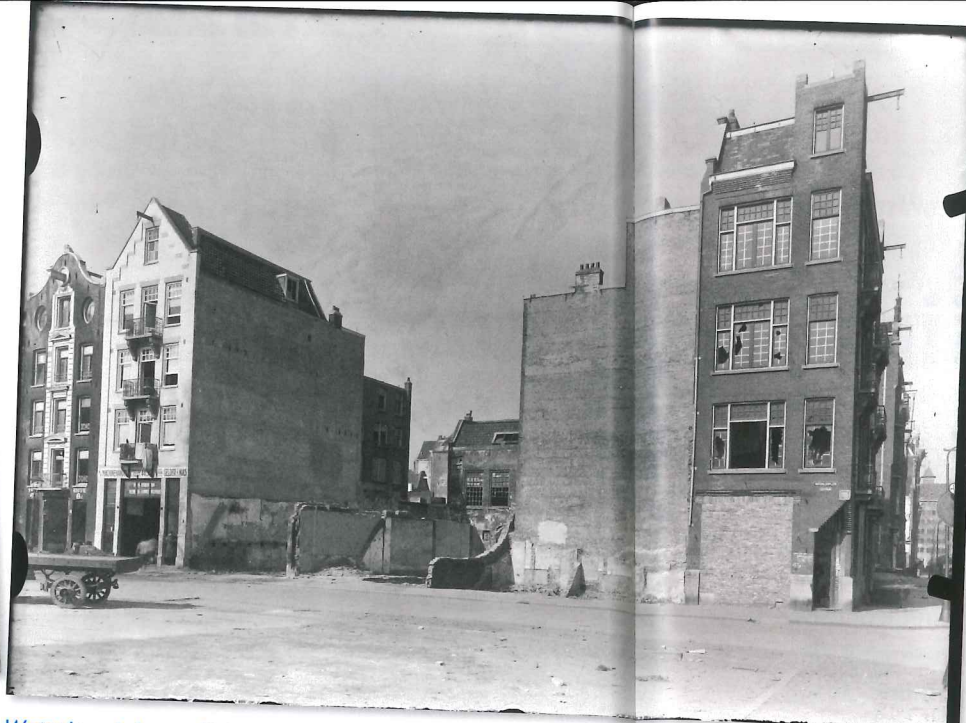
Waterlooplein, april 1946. Van de huizenrij 64-78 staat alleen hoekpand nr 64 nog overeind.
